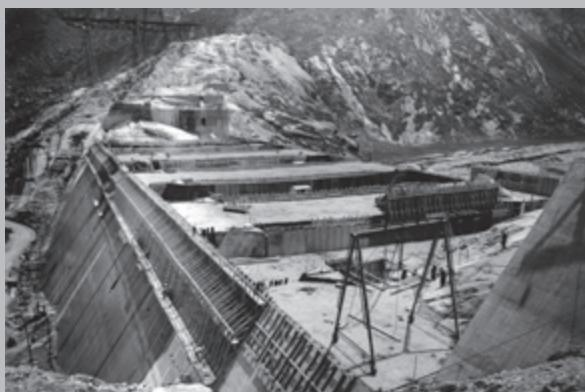
Die Staumauer wurde als sogenannte Schwergewichtsmauer mit einer Höhe von 115 und einer Länge von 750 Metern gebaut. Die Arbeiten dauerten von 1956 bis 1959 und verschlangen alles in allem fast eine Million Kubikmeter Beton.
