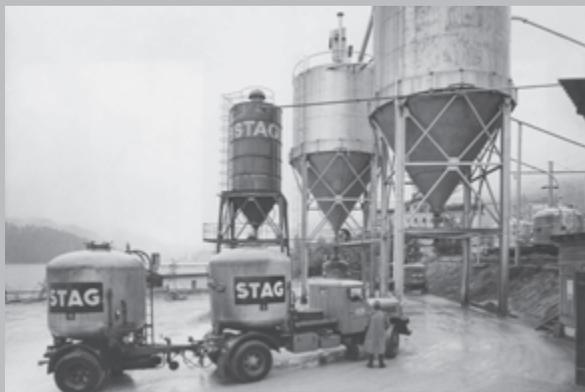
Der Zementumschlag Schiene-Strasse in St. Moritz. Die grossen Silos dienen als Zwischenlager für die täglich bis zu 1000 Tonnen Zement, welche die RhB von Untervaz ins Engadin transportierte.
