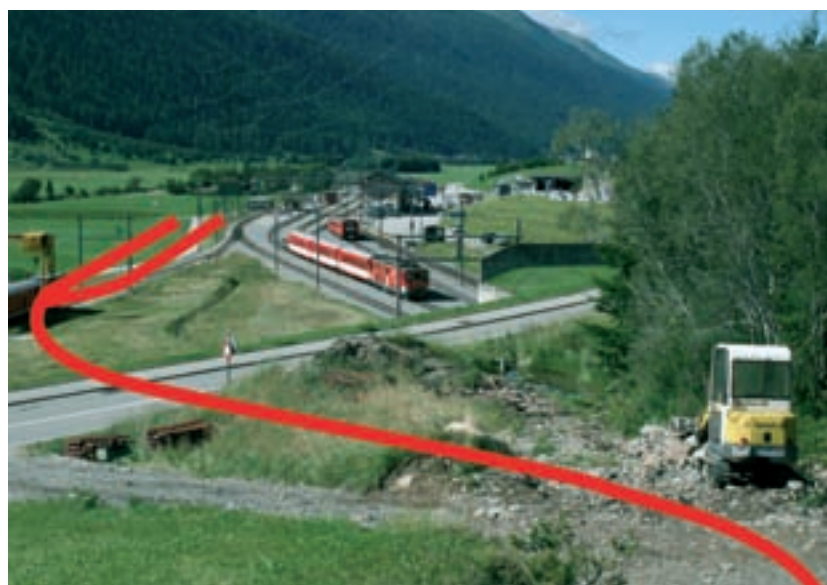
Das noch fehlende Anschlussbauwerk beim Bahnhof Oberwald wird im Sommer 2009 gebaut.
