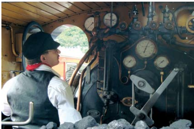
Der Heizer ist immer darauf bedacht, den Betriebsdruck zu halten
