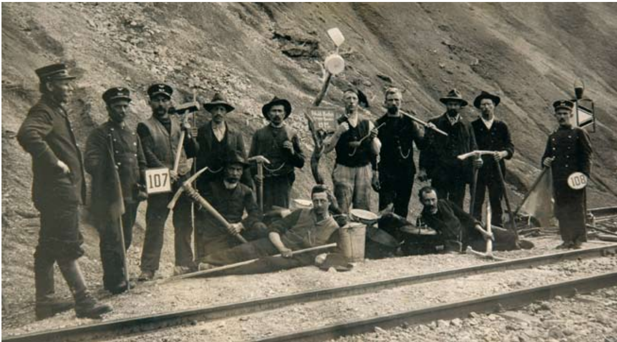
Gleisarbeiter, Sicherheitswärter und Rottenköche der RhB posieren mit Schalk an der neu-erstellten Bahnlinie.
