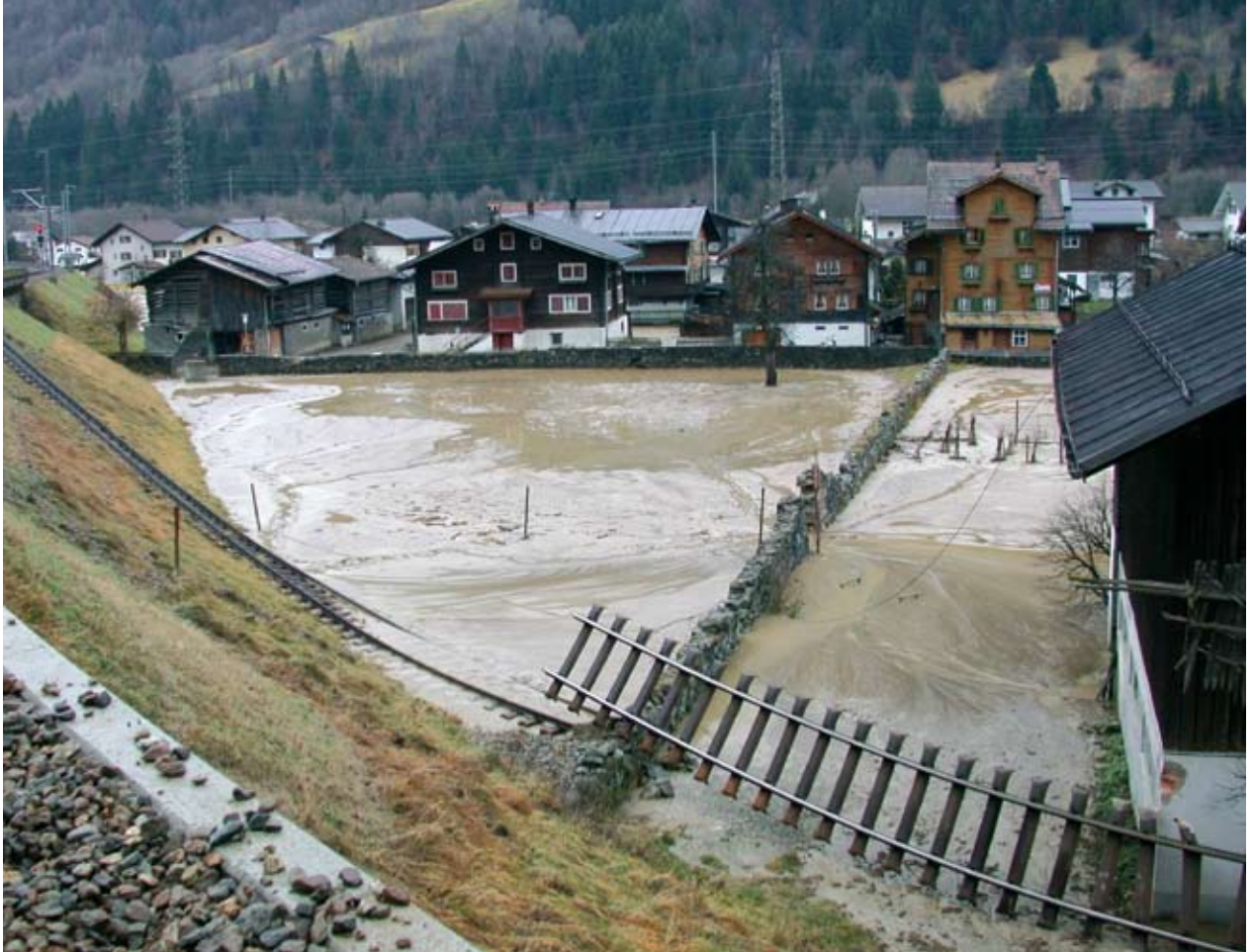
So haben die Unwetter vom November 2002 die Geleisanlagen bei Trun weggespült und verbogen.
