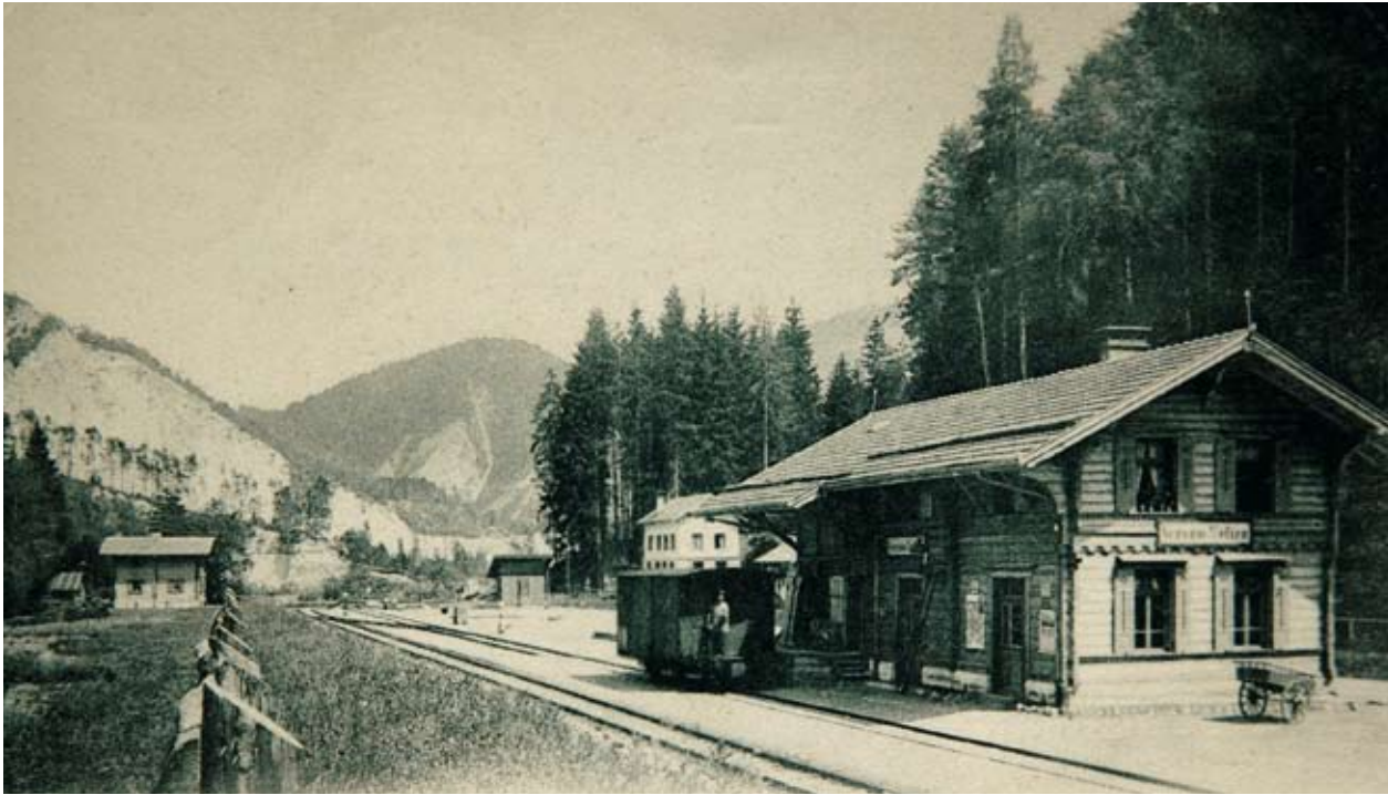
Der Bahnhof von Versam-Safien zeigt den RhB-typischen Grundriss mit Bahnwärterhäuschen (links) zur Zeit der Bahneröffnung.
