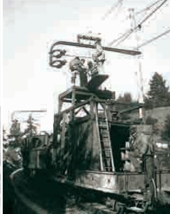
Für die Elektrifizierung gelangten auch auf dem Stammnetz eiserne Ausleger der Siemens-Schuckertwerke zum Einsatz (ganz links und rechts), mit Ausnahme der Oberländerlinie, wo billigere Ausleger nach System Kummler & Matter (Mitte) montiert wurden.
