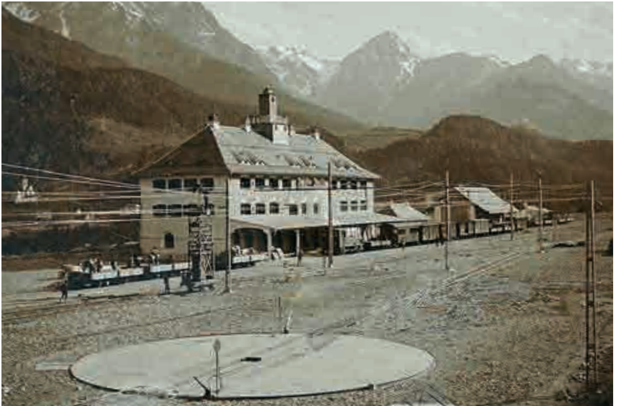
Der Bahnhof Scuol-Tarasp kurz vor dem Eintreffen der ersten elektrischen Lokomotiven. Letzte Arbeiten an der Fahrleitung werden ausgeführt.
