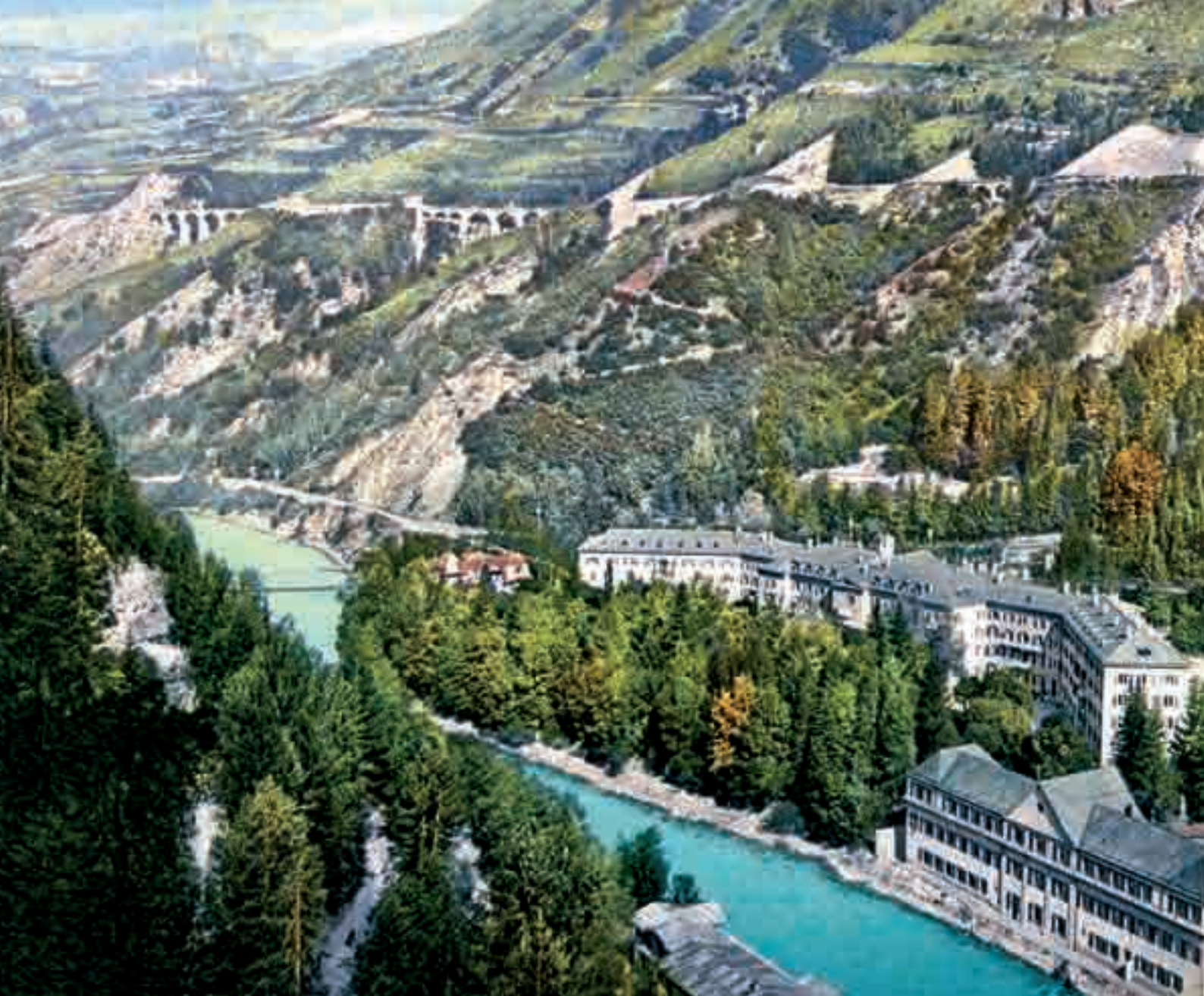
Das ehemalige Kurhaus von Scuol mit vorgelagertem Bäder- und Ökonomiegebäude sowie das neue, grosszügig angelegte Bahntrasse der RhB mit den Viadukten Lumes, Val Corgnanca, Nairs Pitschen und Nairs (v.l.n.r.).
