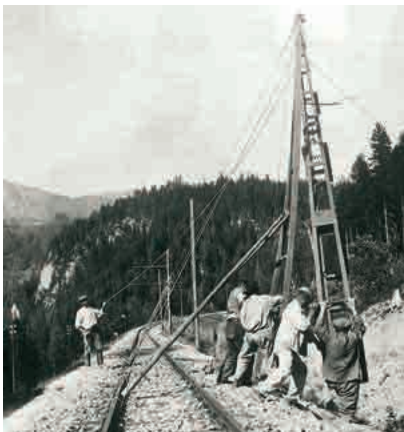
Mit reiner Manneskraft werden die Fahrleitungsmasten aufgerichtet.
