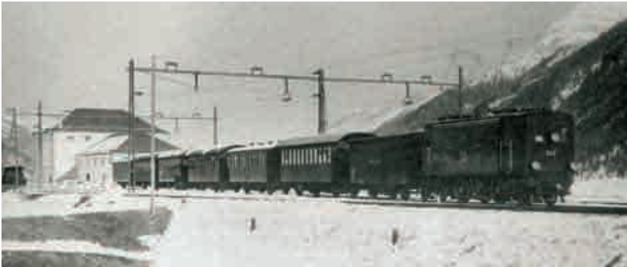
Probezug im Winter 1913 mit Ge 2/4 201; in Bever; im Hintergrund befindet sich das Umformgebäude.
