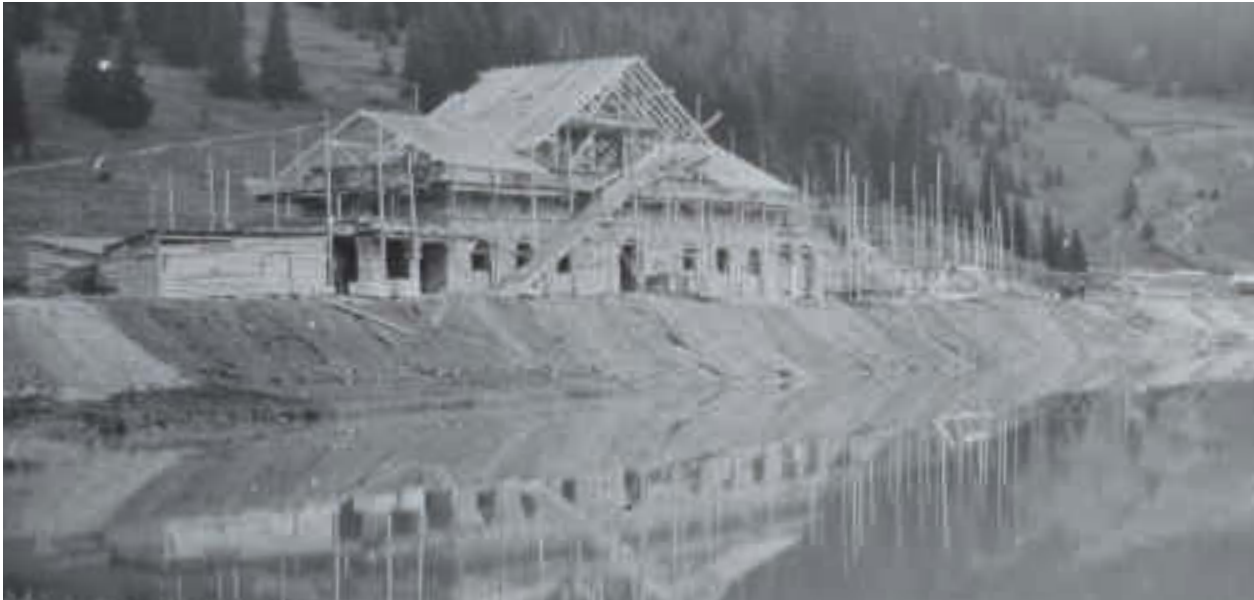
Der Rohbau des neuen Bahnhofs Arosa ist erstellt (1913).
