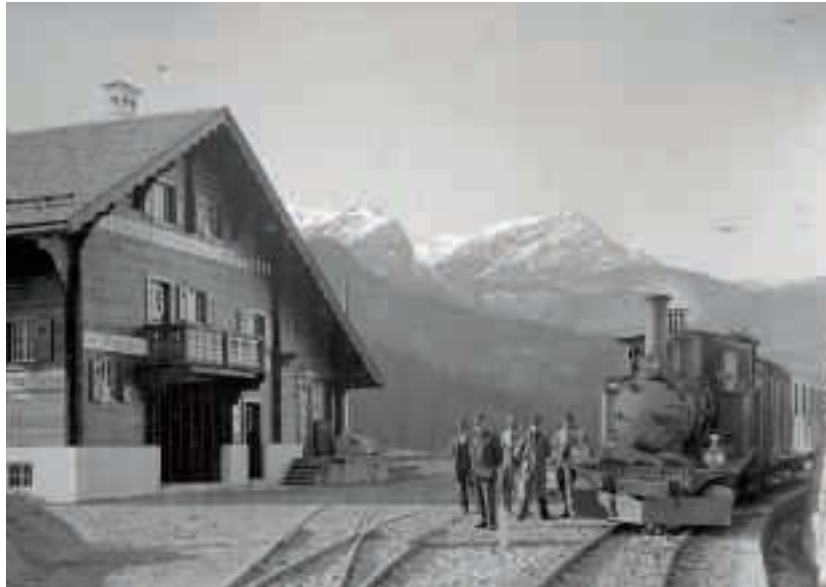
Fotohalt mit Dampfzug in St. Peter-Molinis. Wegen einer im Ausland blockierten Kupfersendung (Kriegsausbruch) fehlen im Herbst 1914 die Fahrleitungen! Die Verantwortlichen ziehen eine Betriebsaufnahme mit Dampftraktion in Betracht.
