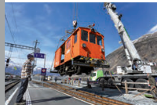
In der Luft: Am frühen Nachmittag hob ein Pneu- kran den 13 Tonnen schweren Gepäcktriebwagen definitiv vom RhB-Netz.
