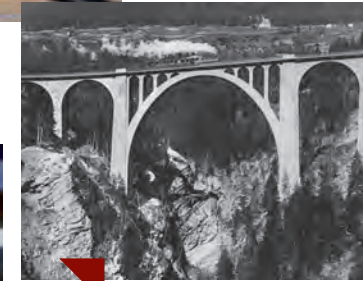
68 STEINERNE BAHNBRÜCKEN, EIN MARKENZEICHEN DER RhB
