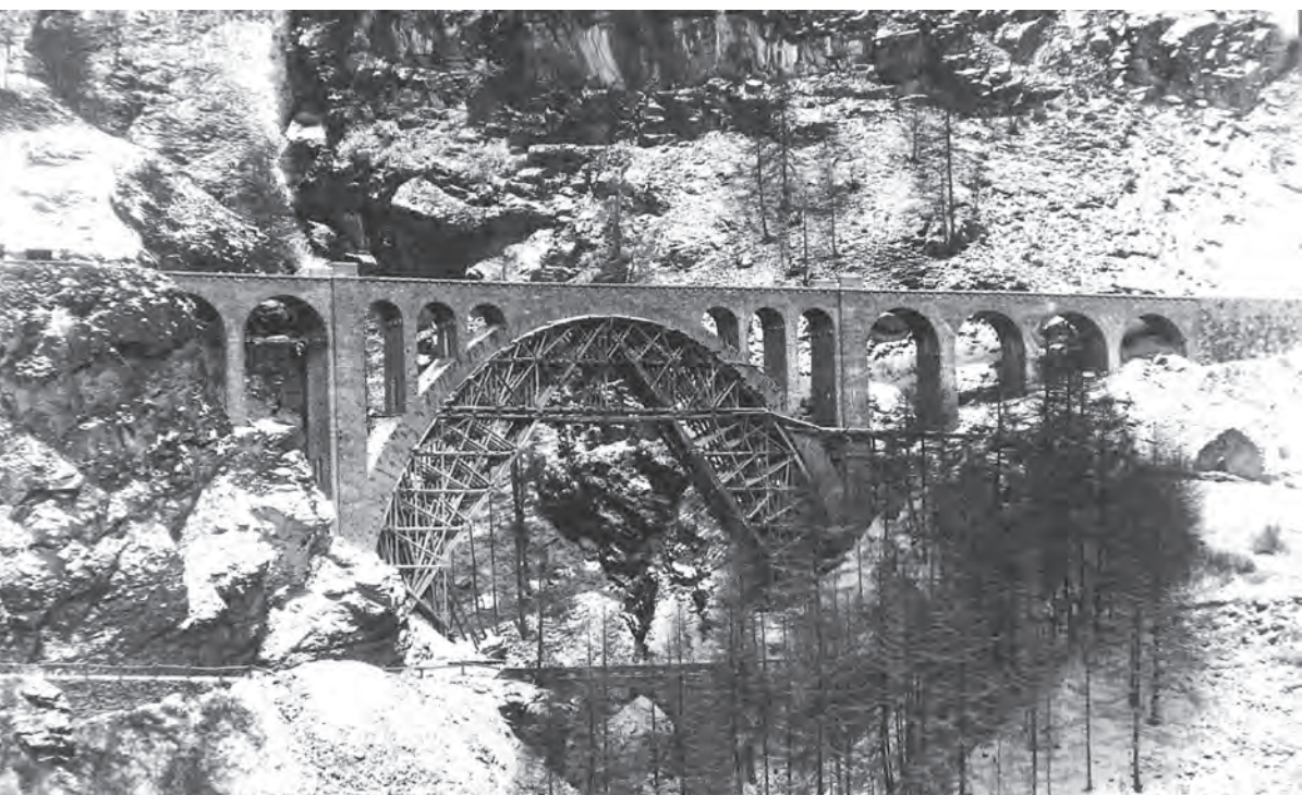
Der Val-Tuoi-Viadukt während des Baus mit gut erkennbarer Parabelform. Archiv RhB
